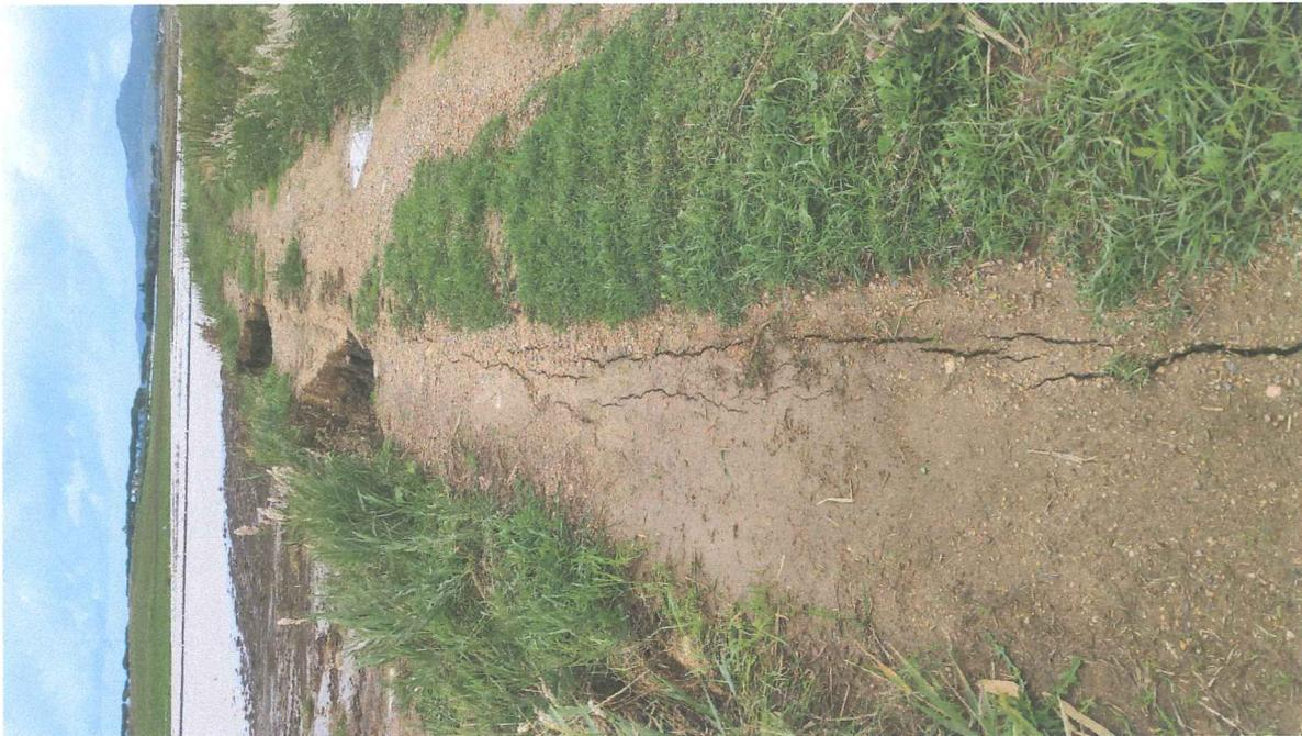
*Foto 1 - Vista erosione arginale, Canale delle Basse (DX idraulica)*
