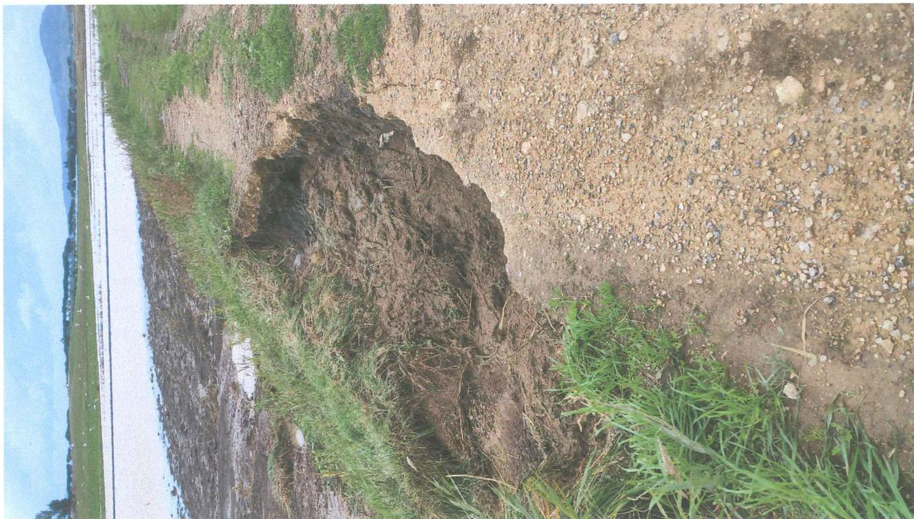
*Foto 3 – Erosioni diffuse, Canale delle Basse (DX idraulica)*
