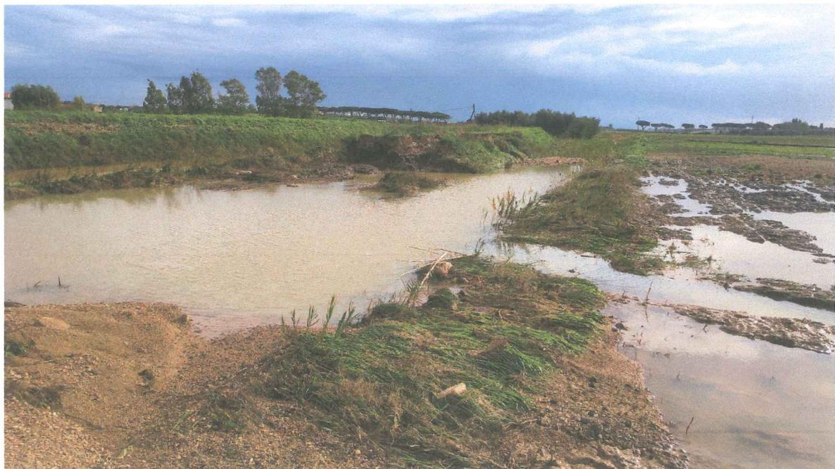
*Foto 2 - Vista rottura argine, Canale delle Basse (DX idraulica)*
