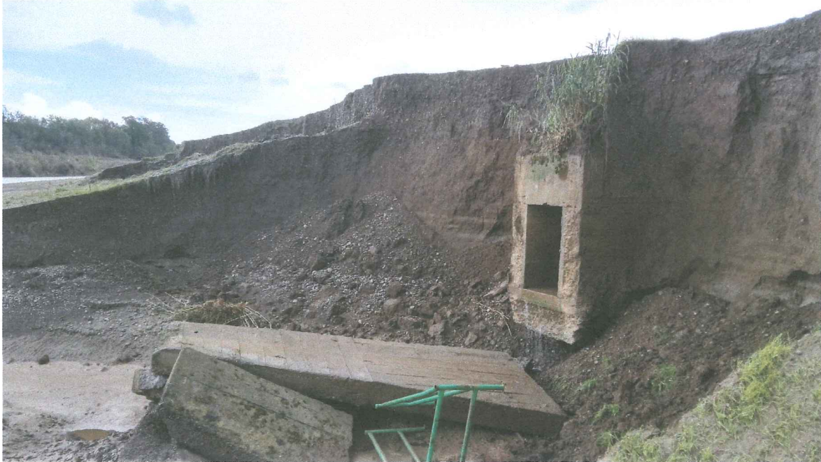
Foto 3 – Fiume Albegna demolizione ventola di scarico (DX idraulica)
