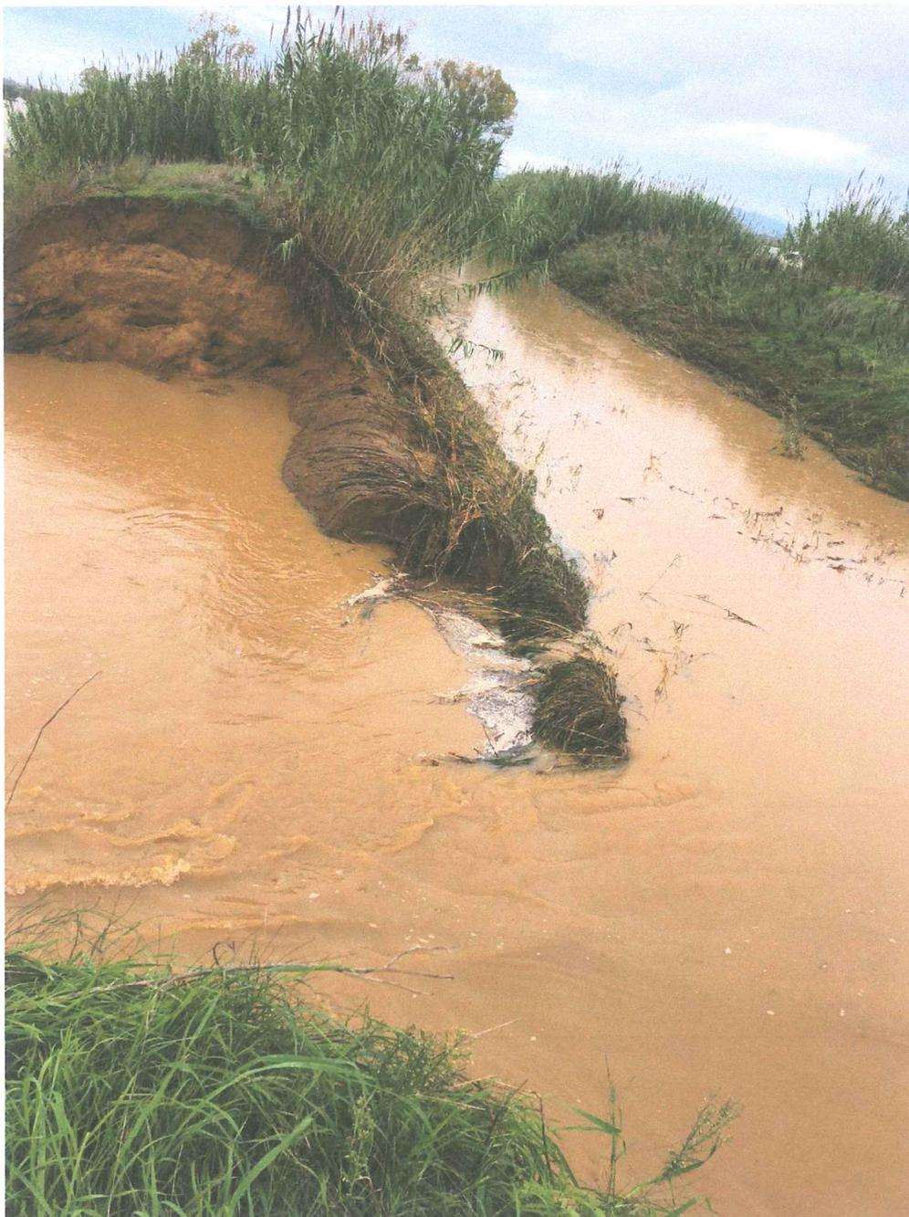
*Foto 1 - Vista rottura argine, fosso Rispescia (SX idraulica)*
