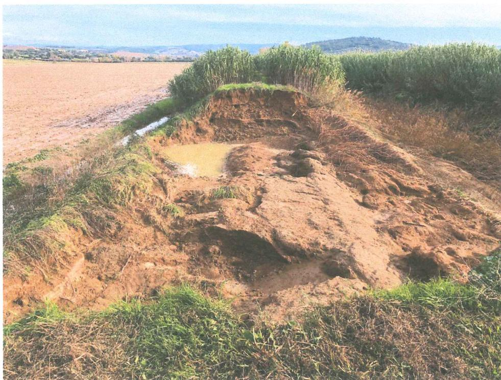
*Foto 3 - Vista rottura argine, fosso Rispecchia (SX idraulica)*
